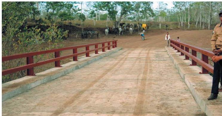
Puentes Bailey en Siuna-Rosita-Puerto Cabezas, que sirvió para dar respuestas a comunidades incomunicadas en esas zonas.
